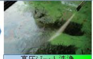
高圧ジェット洗浄
