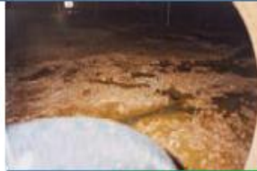
残油スラッジ抜取
