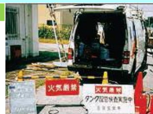
地下タンク・配管検査作業
