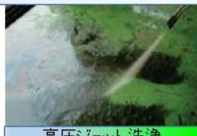
高圧ジェット洗浄
