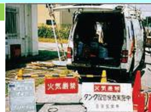
地下タンク・配管検査作業
