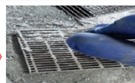
グレーチング清掃
