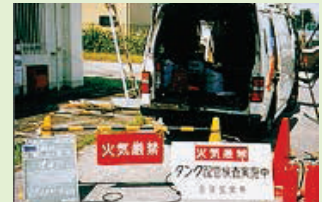
地下タンク・配管検査作業
